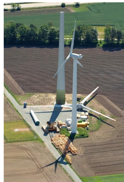
zusammengebaute Rotorblätter vor Anhebung auf Turm
