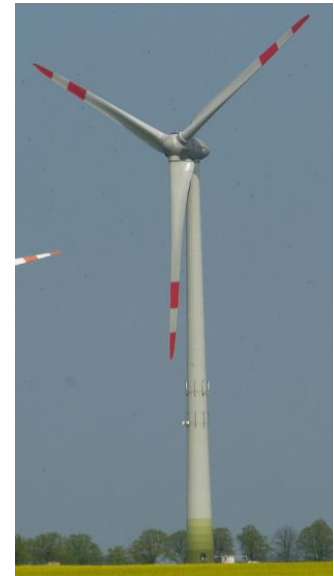
Rotordurchmesser 101m Nabenhöhe 99m 3 MW Nennleistung
