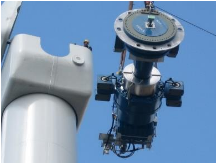
Eibau eines Getriebes mit Generator in die Gondel
